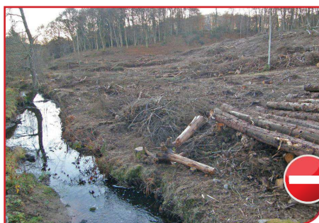
Changement brutal de l'environnement immédiat, suppression ripsylve.
